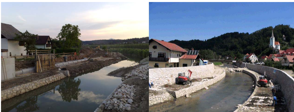
Slika 4: Ureditev reke Hudinje, izgradnja protipoplavnih zidov in nasipov (foto: Urban Podergajs)
