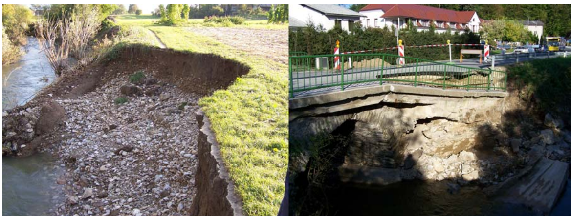
Slika 7: Poškodbe na kmetijskih površinah in infrastrukturi (foto: Urban Podergajs)
