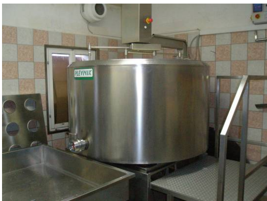
Slika 19: Segrevanje mleka v kotlu s pomočjo centralne kurjave, proizvajalec 3
