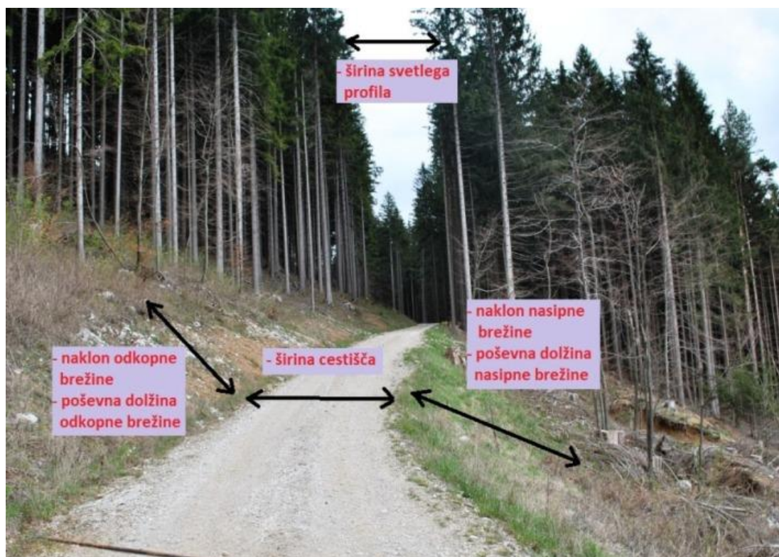
Slika 2: Prikaz merjenih elementov prečnega profila gozdne cest (foto: Potočnik M., 2012)
