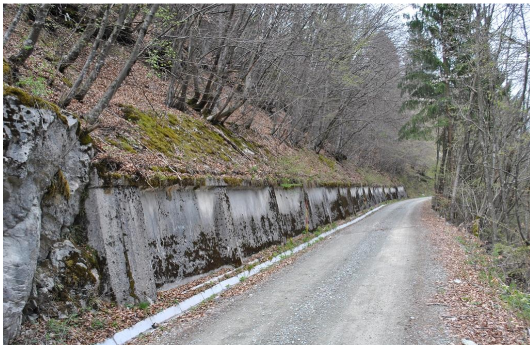
Slika 30: Betonski oporni zid, zgrajen na bolj izpostavljenem mestu na gozdni cesti zgrajeni leta 1937 (foto: Potočnik M.,2012)
