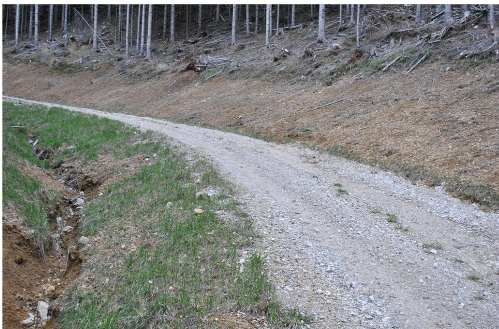
Slika 33: Razlika v zaraščenosti med odkopno in nasipno brežino na cesti zgrajeni leta 2010 (foto: Potočnik M., 2012)
