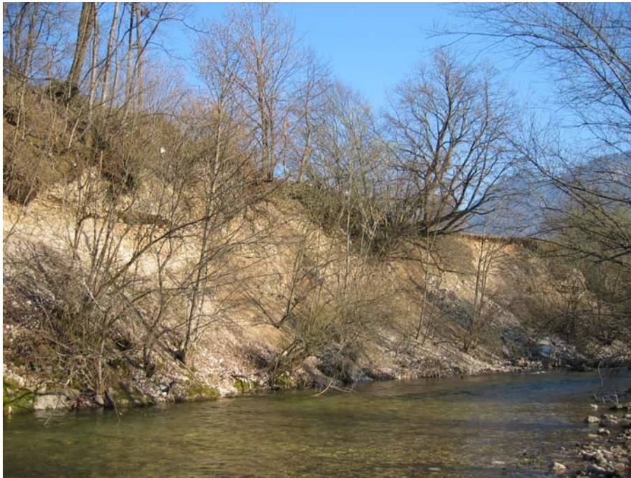
Slika št. 7: Bočna erozija pri kraju Breg, v zaledju je travnik: obrečna drevnina odsotna, ni varovalne funkcije utrjevanja tal.
