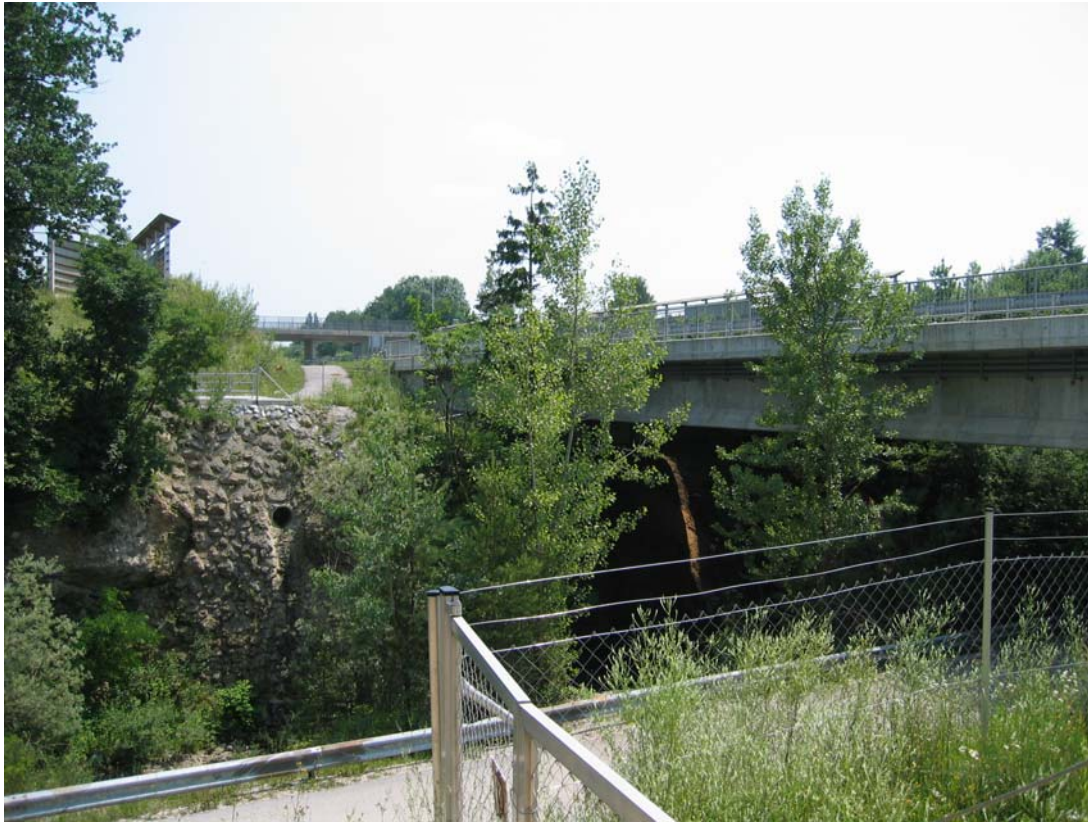
Slika št. 14: Gorenjska AC preseka obvodni koridor. Močan poseg v ekosistemsko celovitost.
