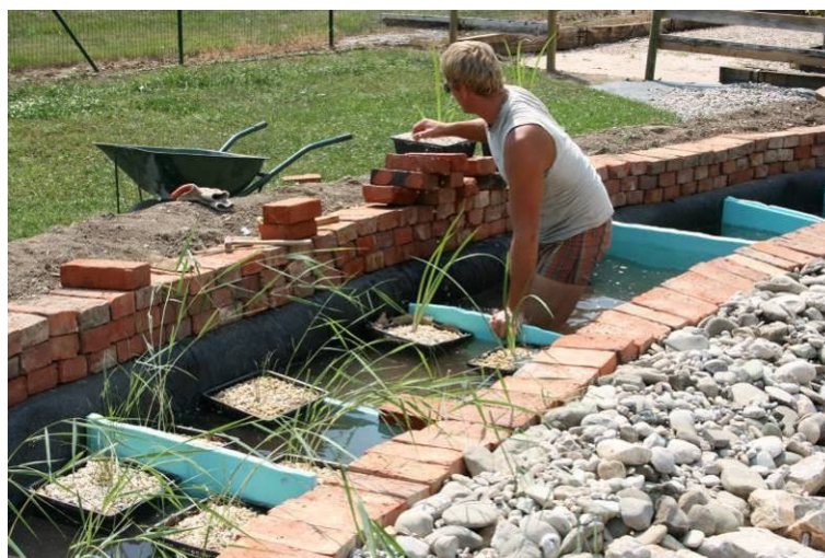
Slika 23: Izdelava in nameščanje bioloških filtrov
