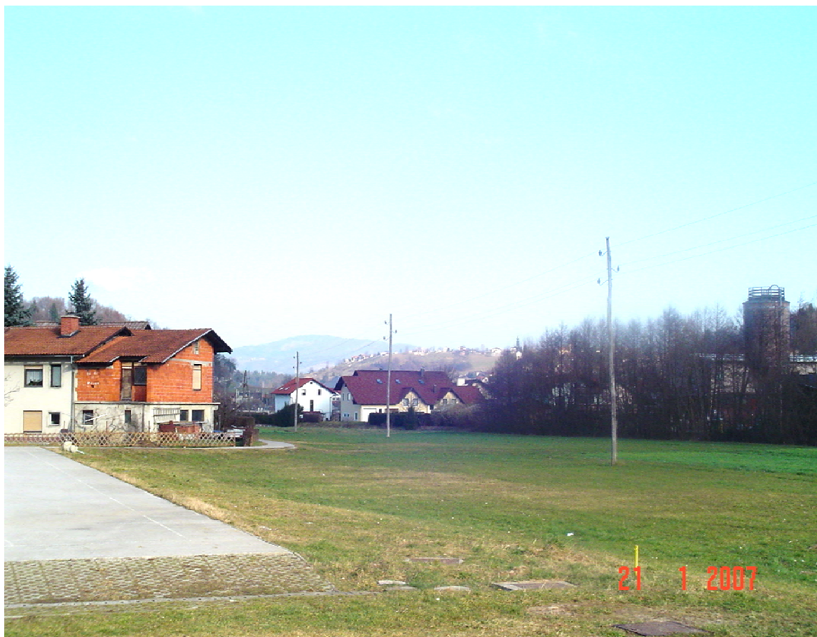
Slika 8: Regulacija potoka pri Hruševcu, danes je oddaljen od hiše 30 m
