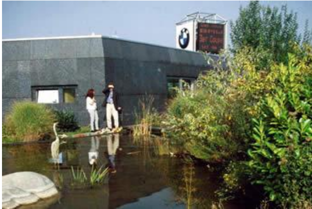
Slika 9: Intenzivni strešni vrt (GreenCraft..., 2009)
