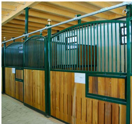
Slika 1: Hlevi za konje v katerem je spodnji del boksa lesen, zgornji pa sestavljen iz kovinskega okvirja in vertikalno postavljenih kovinskih palic (Hlevi, 2010).
