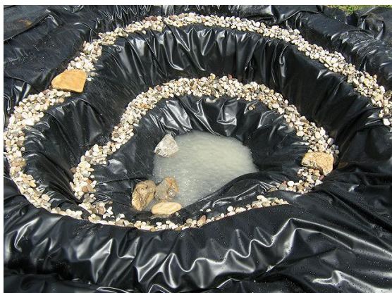
Slika 24: Obložena folija po sadilnih terasah s peskom
