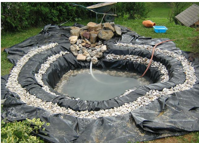
Slika 17: Jarek okoli ribnika zasut z peskom za boljšo učvrstitev folije
