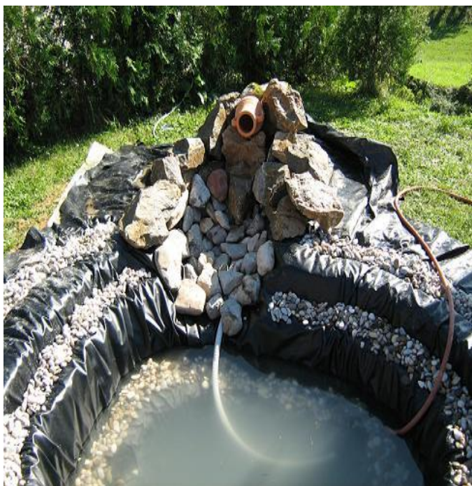
Slika 20: Dovod cevi od črpalke do slapa
