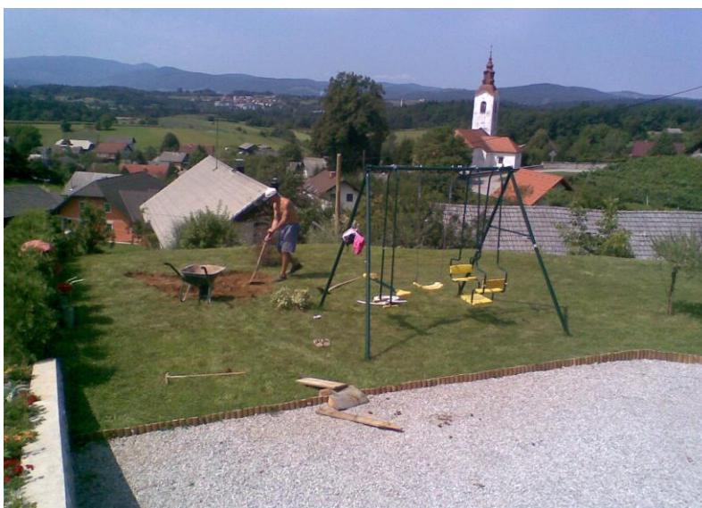
Slika 14: Začetek gradnje ribnika
