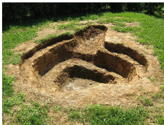
Slika 16: Izkopan stopničast ribnik
