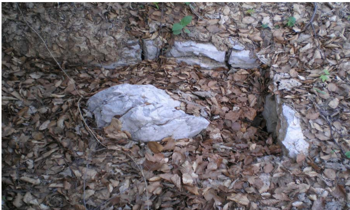
Slika 7: Zamašen vtočni jašek (Foto: Šega, 2008)
