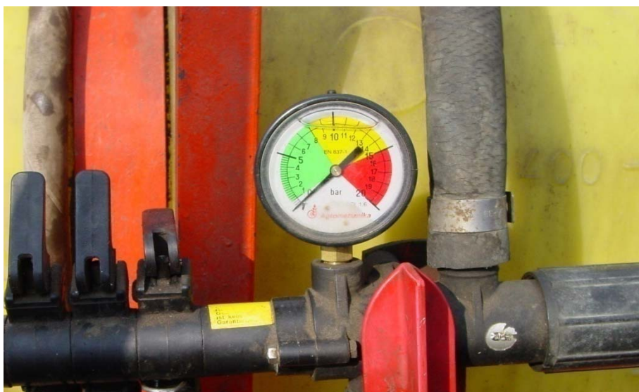
Slika 18: Napačen manometer (foto: V. Škedelj)
