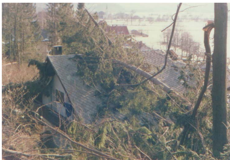
Slika 1: Vetrolom je poškodoval stanovanjsko hišo
