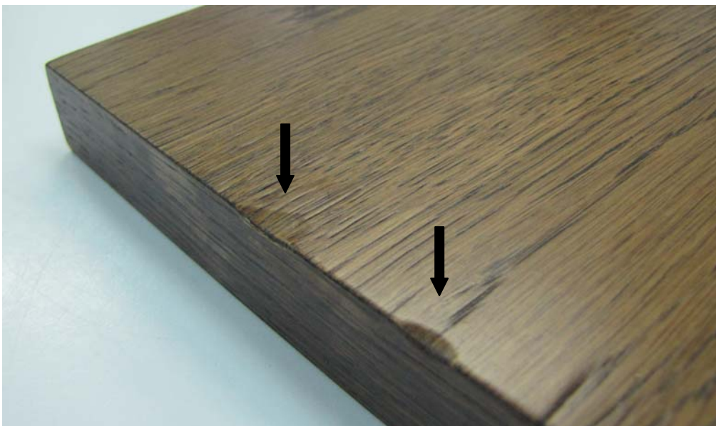
Slika 9: Poškodovan rob plošče
