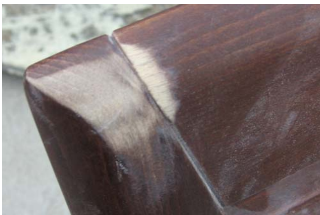
Slika 15: Obrušen kit
