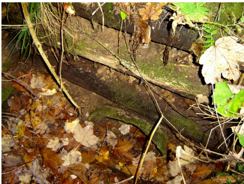
Slika 14: Dotrajan in zamašen lesen vtočni jašek brez pokrova (Foto: Šturm, 2006)
