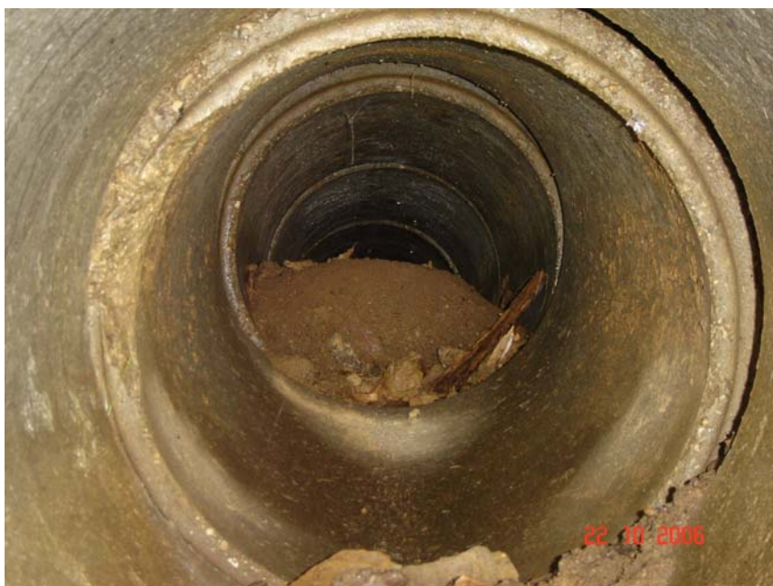
Slika 10: Razmaknjenost med posameznimi sestavnimi deli cevi (Foto: Šturm, 2006)
