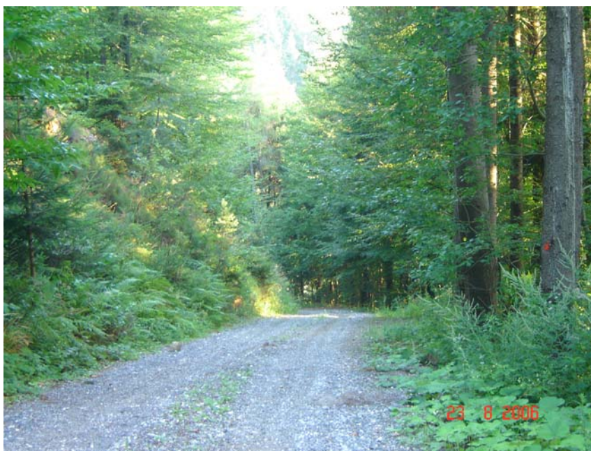
Slika 17: Zaraščenost cestišča (Foto: Šturm, 2006)
