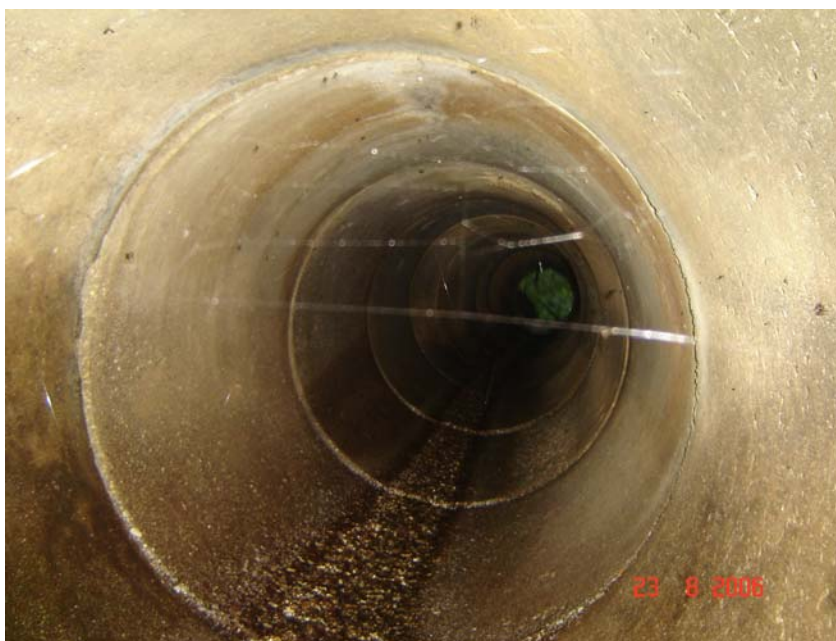
Slika 5: Cev premera 80cm s stalno tekočo vodo (Foto: Šturm, 2006)
