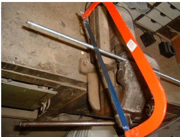
Slika 42: Razrez navojne palice
