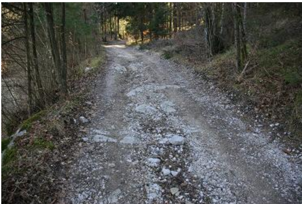
Slika 7: Načeta obrabna plast (foto: G. Tomazin)
