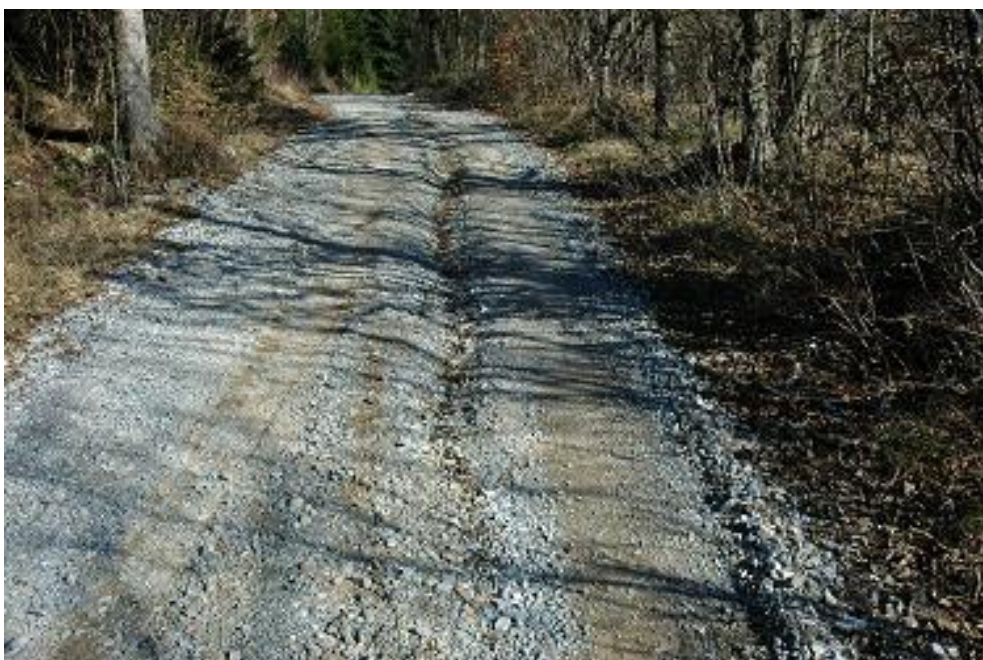
Slika 8: Erozijski žlebovi (foto: G. Tomazin)
