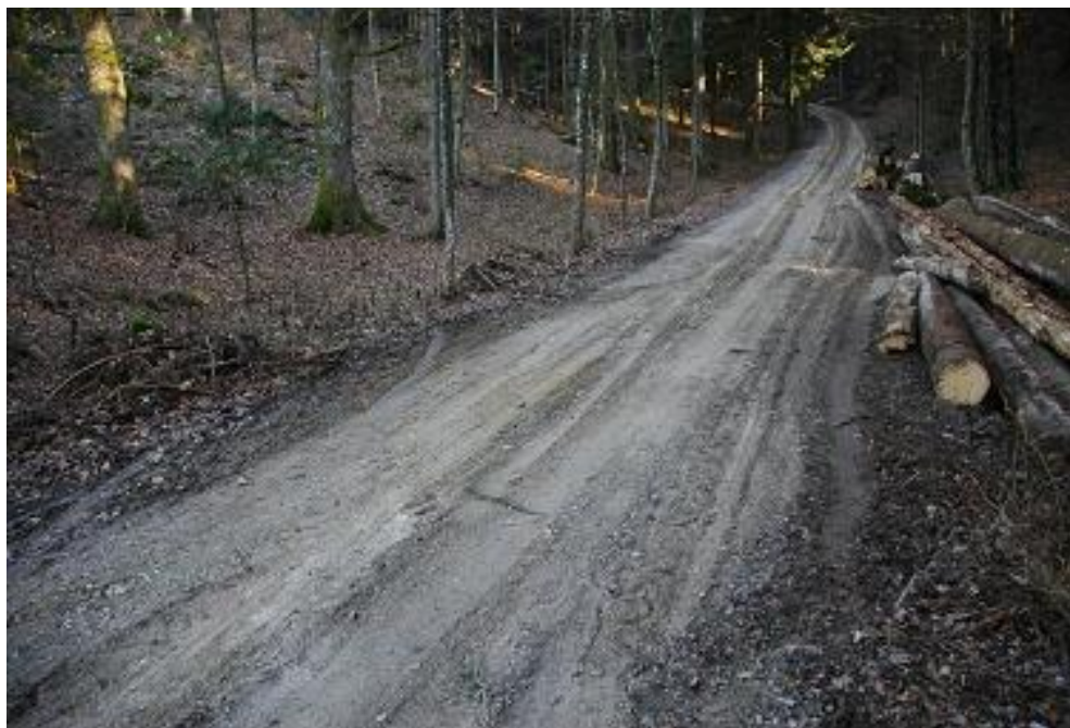
Slika 10: Nanos materiala zaradi vlačanja lesa (foto: G. Tomazin)
