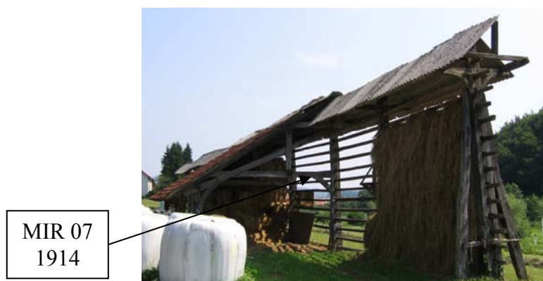
Slika 44: Ocvirkov kozolec z označenim mestom odvzema izvrtka ter datumom datacije
