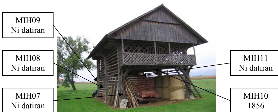
Slika 55: Krhinov toplar z označenimi mesti odvzema izvrtkov ter datumom datacije
