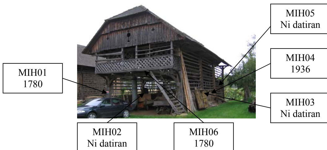
Slika 52: Divjakov toplar z označenimi mesti odvzema izvrtkov ter datumi datacije
