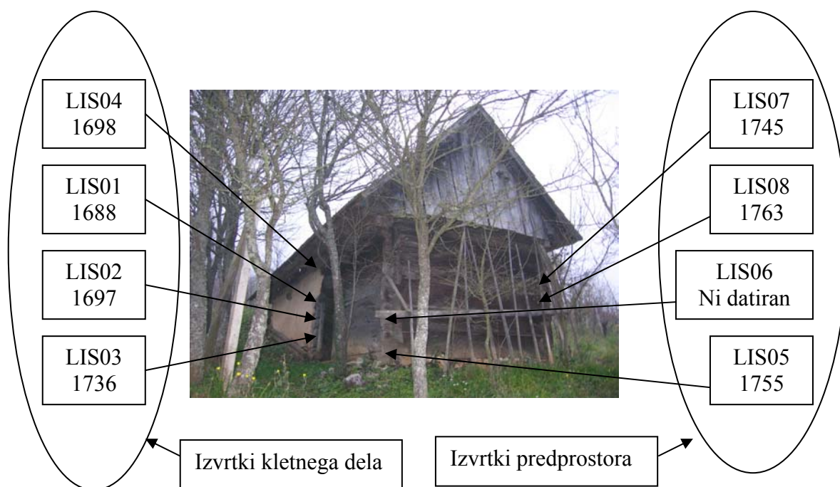
Slika 74: Pekoljev hram z označenimi mesti odvzema izvrtkov ter datumi datacije
