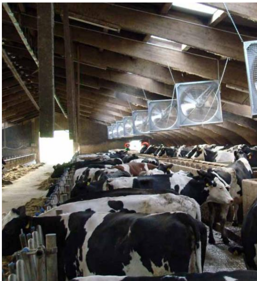
Slika 12: Mešalno prezračevanje (Mešalno/tunelsko ..., 2015)
