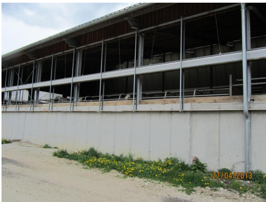
Slika 10: Prečno zračenje hleva (Foto: Vranjek, 2013)
