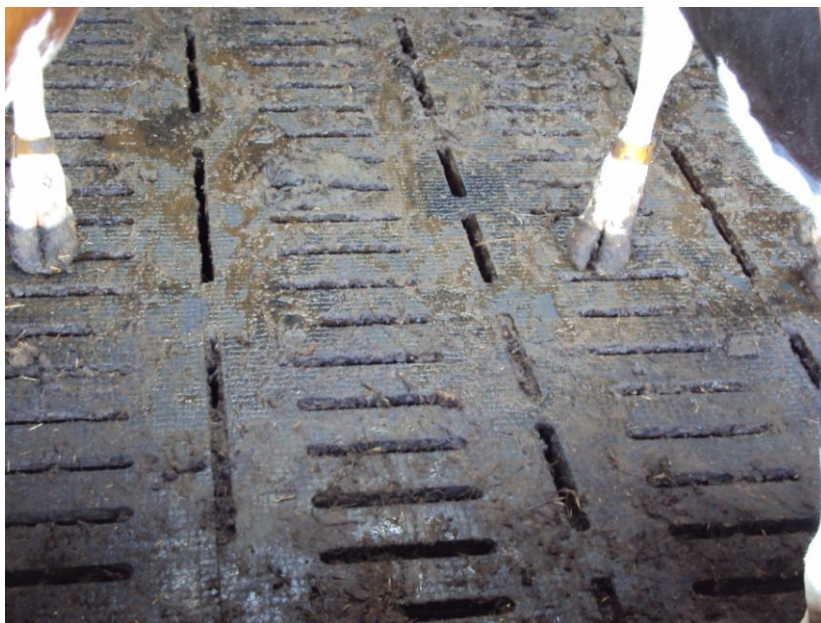
Slika 15: Rešetkasta tla, prekrita z gumo (Foto: Vranjek, 2013)
