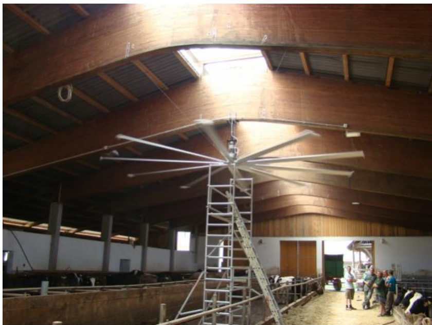
Slika 13: Vertikalno prezračevanje (Stropni ..., 2015: 7)
