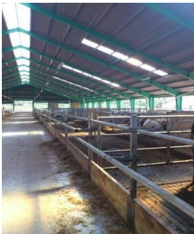
Slika 8: Za svetlobo prepustno območje na strehi in odprte stene (Foto: Vranjek, 2013)
